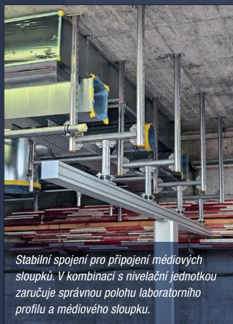
3rozměrný upevňovací rastr pro oblasti s vysokou hustotou instalace a s vysokými požadavky na flexibilitu.
