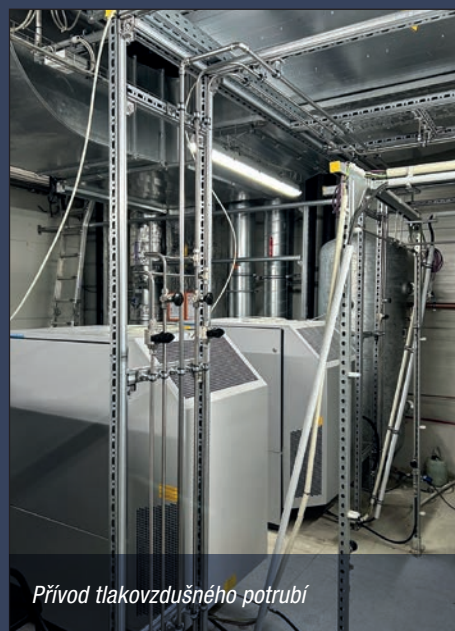
3rozměrný upevňovací rastr pro oblasti s vysokou hustotou instalace a s vysokými požadavky na flexibilitu.
